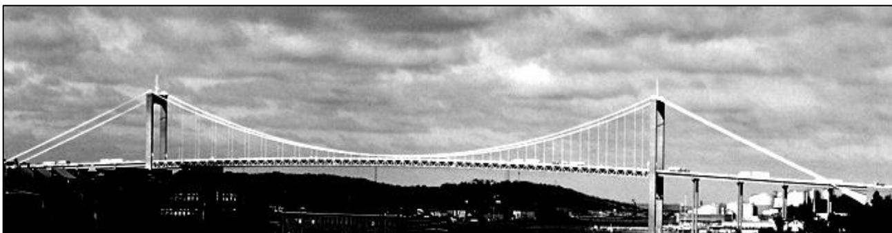
Das Foto oben zeigt eine Hängebrücke. Die Stahlseile sind in einer Höhe von 80 m über der Straße an den Brückenpfeilern befestigt.
